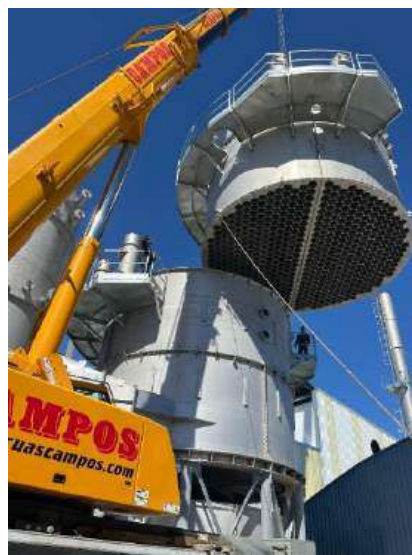
Proceso de instalación del nuevo electrofiltro
